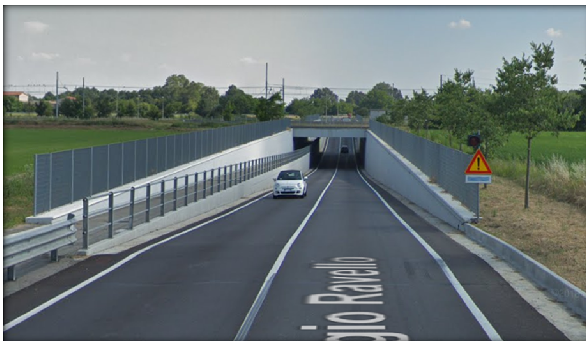
Foto 5 – Sottopasso linea ferroviaria Albairate-Vermezzo
