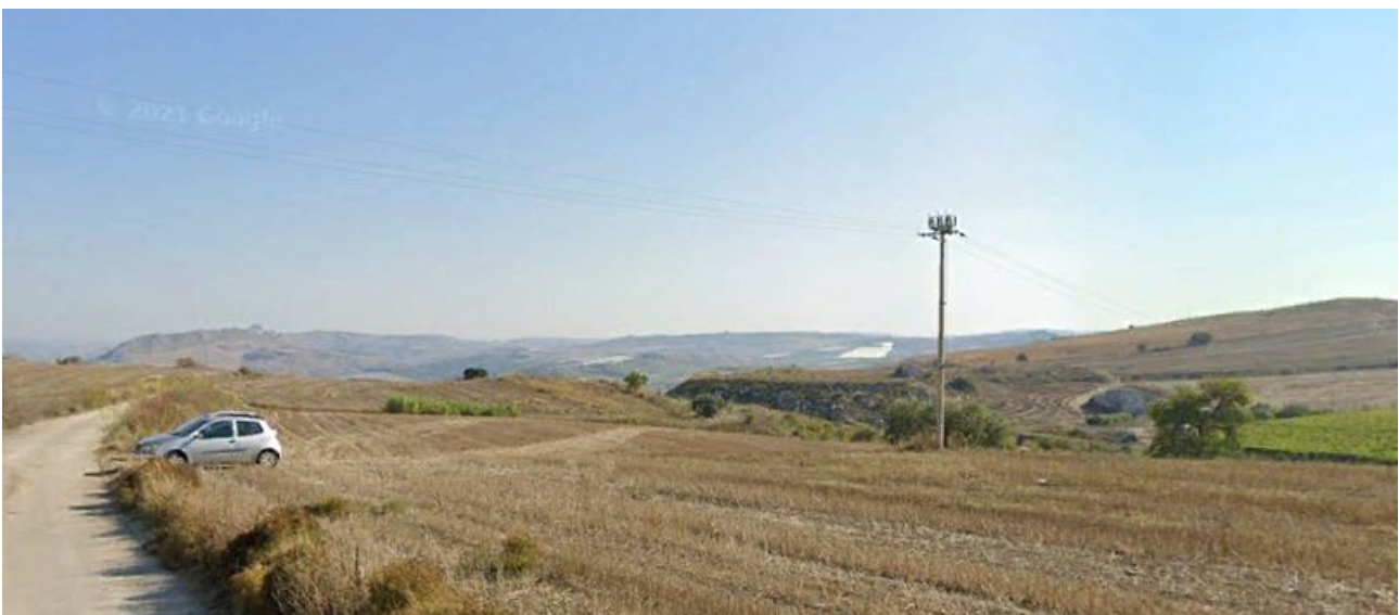
Figura 35: linee elettriche nell'area.
