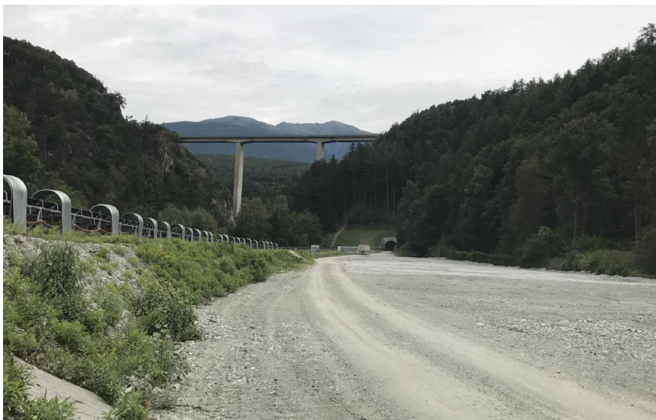
Fig. 3 - Ripiano di base adiacente al fiume Isarco attualmente sede del cantiere BBT
