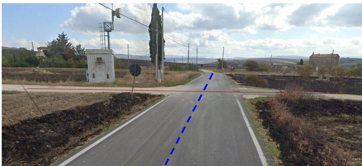
Figura 56 Attraversamento del cavidotto sul tratturo. In blu il cavidotto in TOC mentre in marrone il tratturello che attraversa perpendicolarmente la strada
