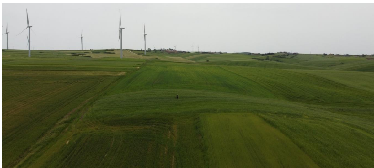
Figura 78 Area di installazione turbina SAB03
