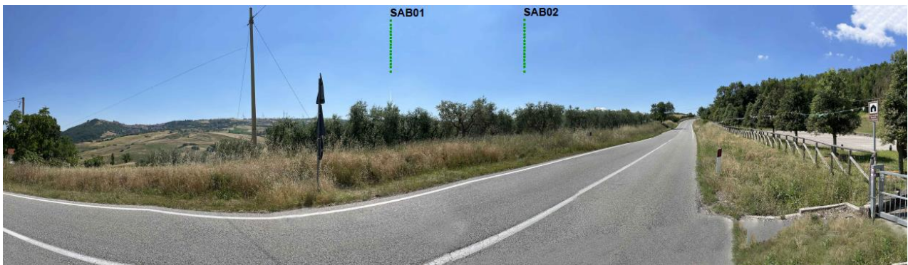
Figura 107 Stato dei luoghi ex post-ID 5
