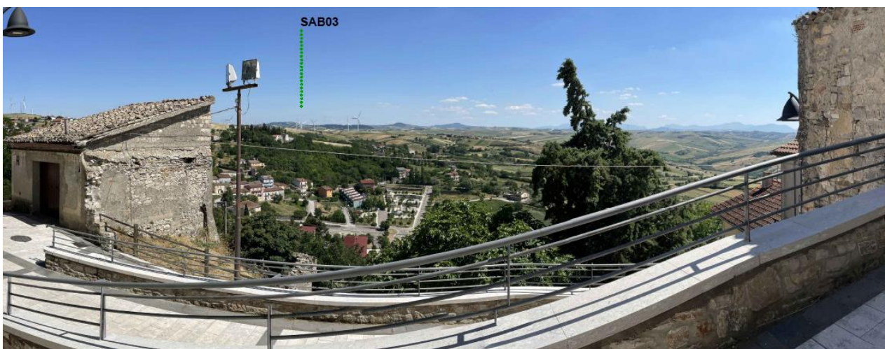
Figura 100 Stato dei luoghi ex post - ID1
