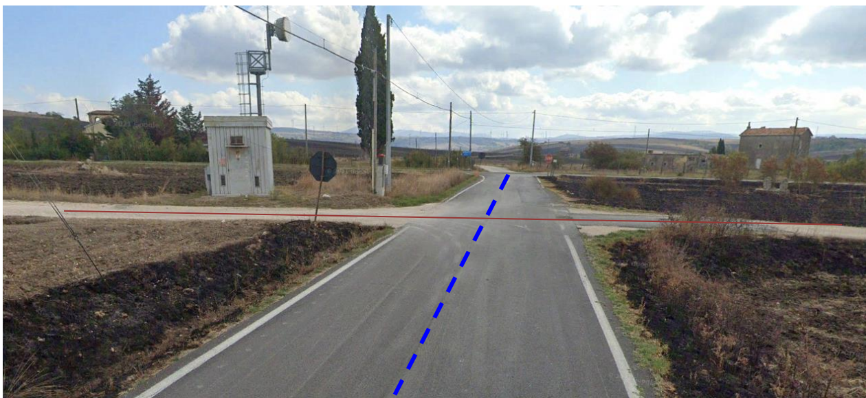
Figura 13 Attraversamento del cavidotto sul tratturo. In blu il cavidotto in TOC mentre in marrone il tratturello che attraversa perpendicolarmente la strada
