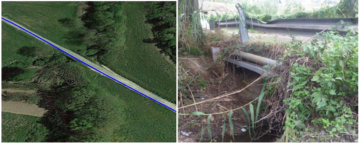
Figura 24 - passaggio C piccolo fosso
