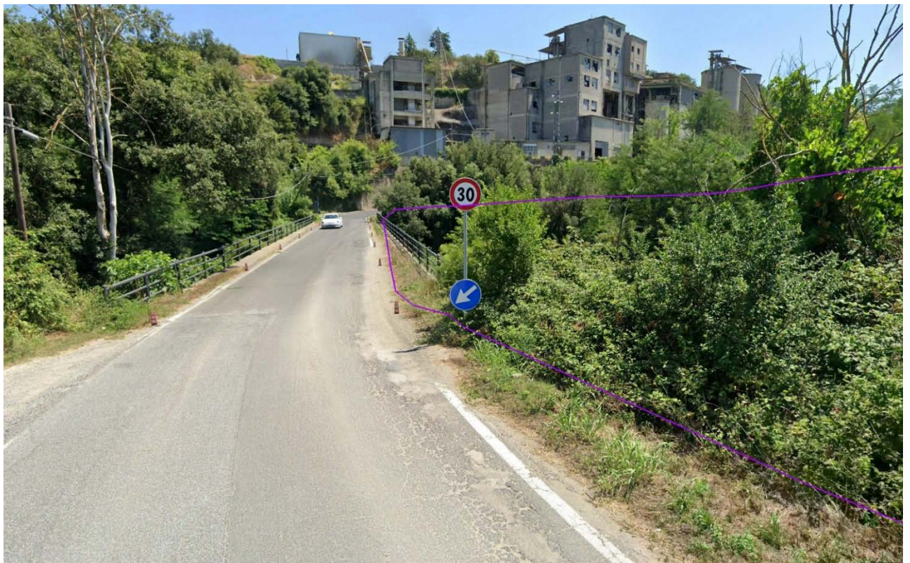
Figura 7 - SP 109: ponte sul Fosso Timone
