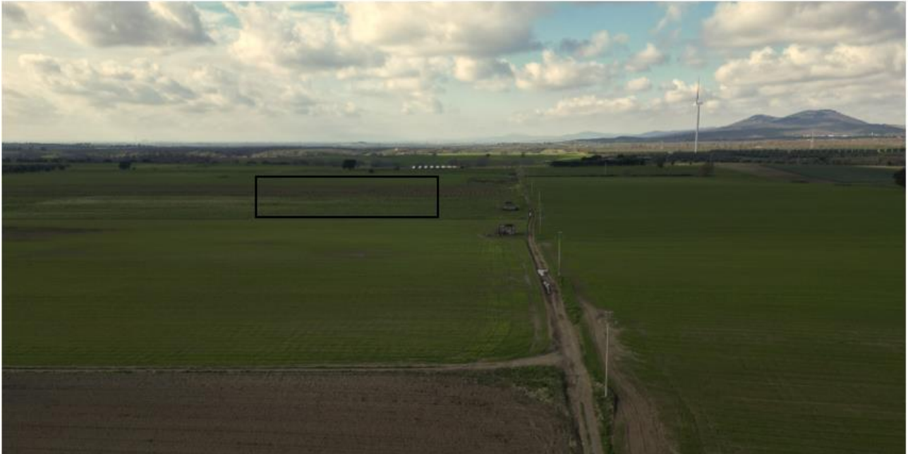
Figura 54 - Area della Sottostazione vista da Est
