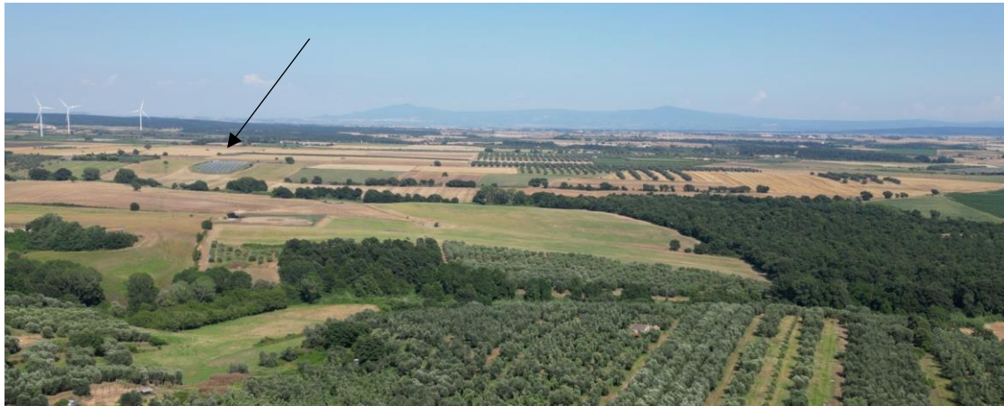
Figura 15 - Area nuova stazione elettrica vista da Canino
