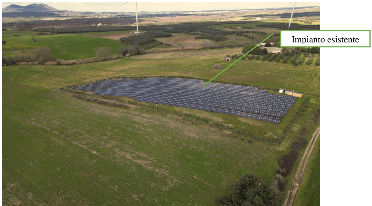
Figura 36 – Impianto fotovoltaico esistente
