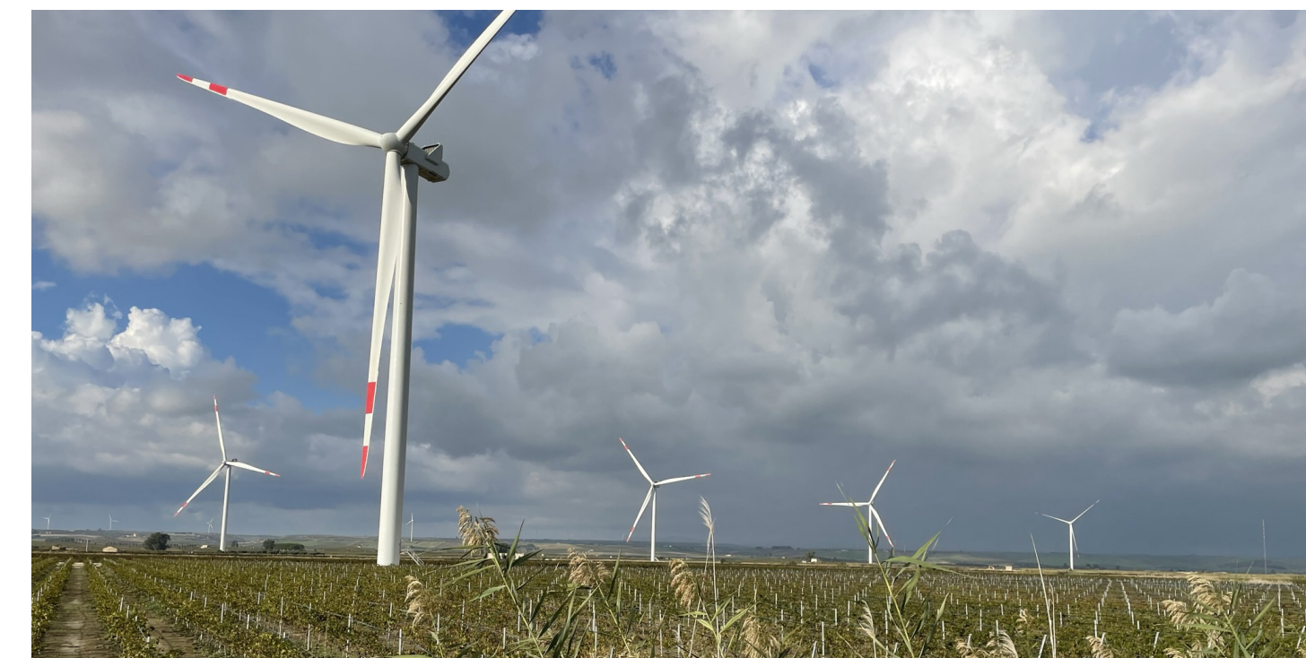
Punto di ripresa n° 13 posto a 19 metri s.l.m. e distante circa 1,53 km dall'aerogen. T05 da cui saranno potenzialmente visibili 9 dei 10 aerogeneratori in progetto. La foto è eseguita dalla strada panoramica SP25.
