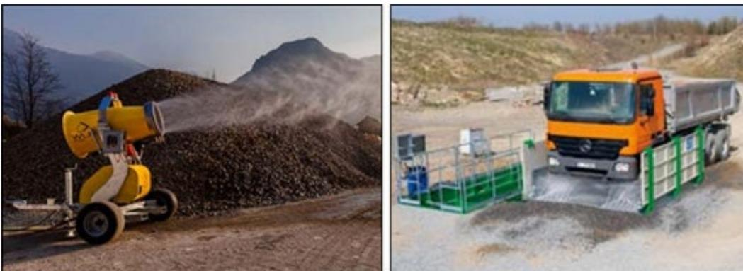
Figura 7.1 - Esempio di Impianto di nebulizzazione mobile (immagine a sx) e di lavaggio ruote (immagine a dx) - (Fonte: web)
