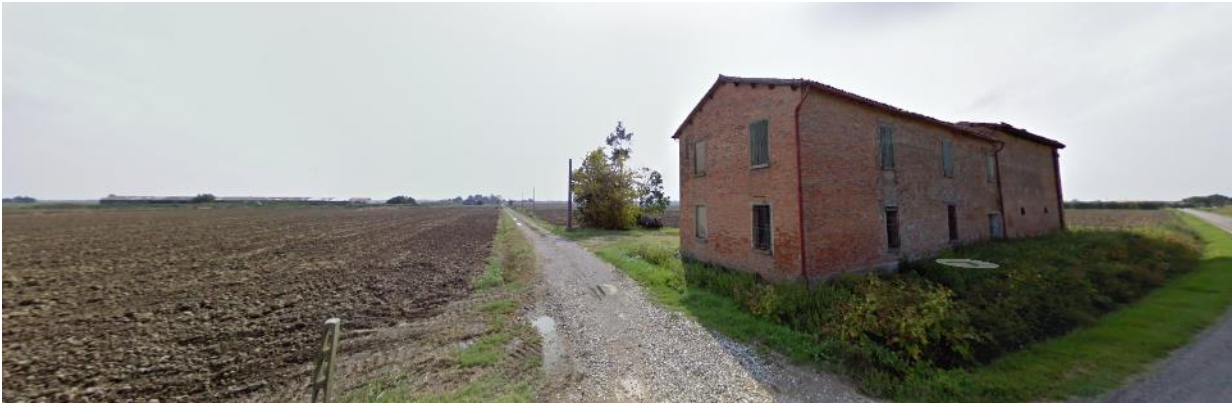
Figura 5.2 – Vista del fabbricato di tipologia rurale semplice, collocato all'angolo nord-orientale dell'ambito di progetto (Fonte: Google Street View)
