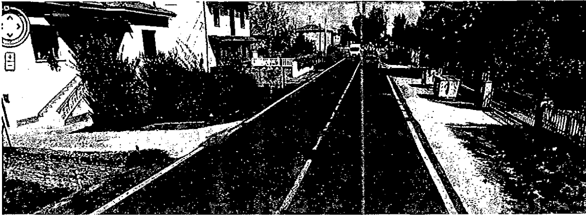
Fig. 6 Nel tratto della SP.6 in prossimità di via Alberelli la presenza di un nucleo edificato rende arduo l'allargamento della piattaforma ed impossibile la messa a norma degli accessi.
