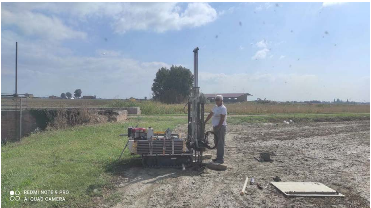
Foto 10: ubicazione sondaggio (altra angolazione)
