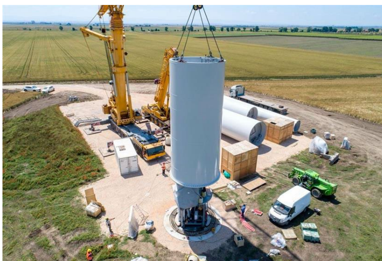
Figura 9 –Piazzola per il montaggio dell'aerogeneratore
