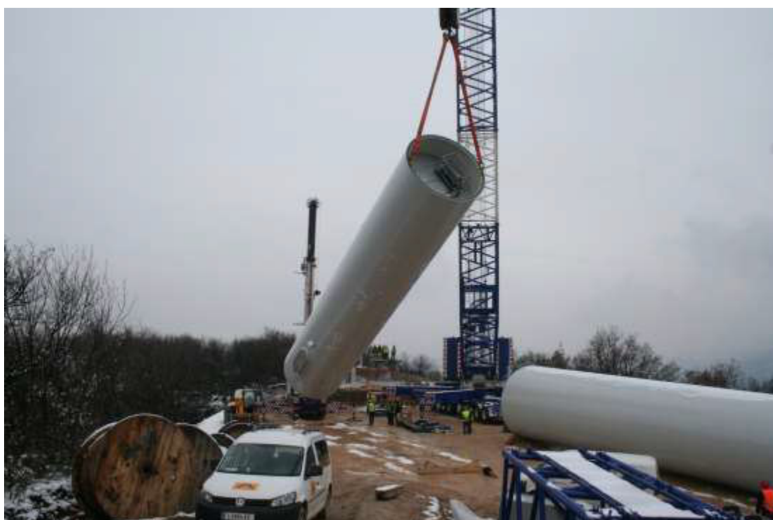
Figura 3. Smontaggio dei tronchi
