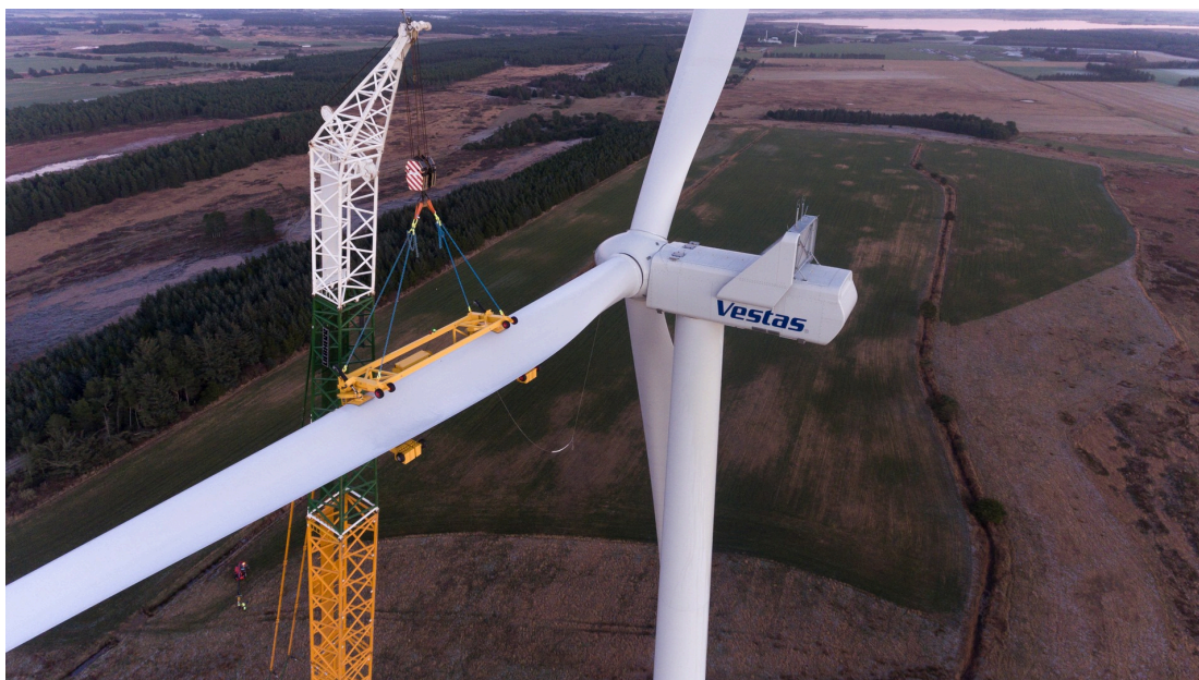
Figura 2. Smontaggio delle pale
