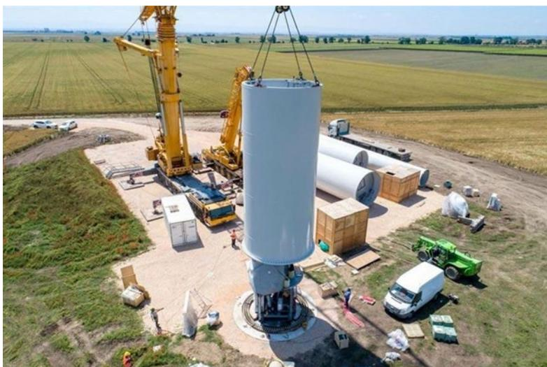
*Figura 6.4 - Piazzola per il montaggio dell’aerogeneratore*
