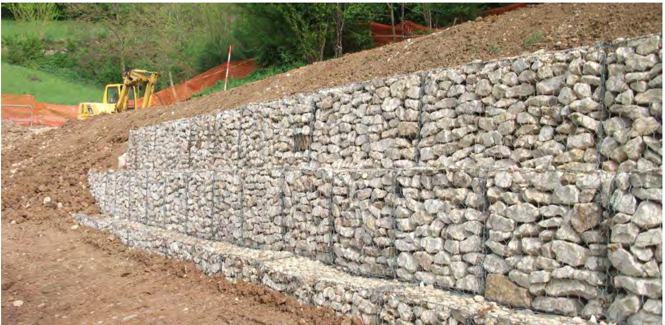
Figura 5. Esempio di gabbionate rinverdite
