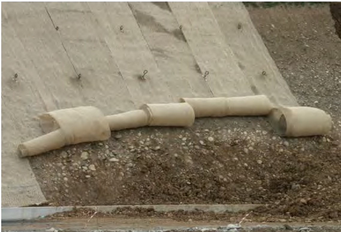
Figura 7. Esempio di rivestimento in geostuoia
