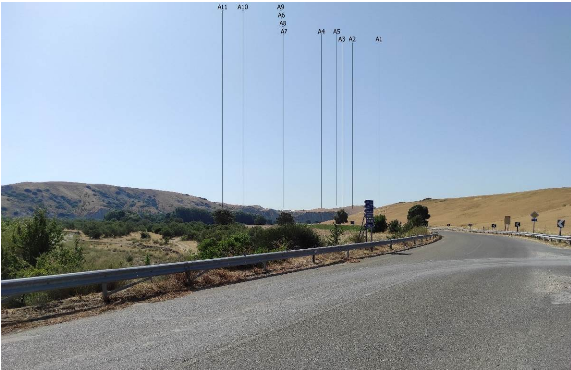
Vista 11 lungo la SP4 (Viadotto Salandrella V), lungo nr. 66 MT tratturo di San Leonardo, post operam
