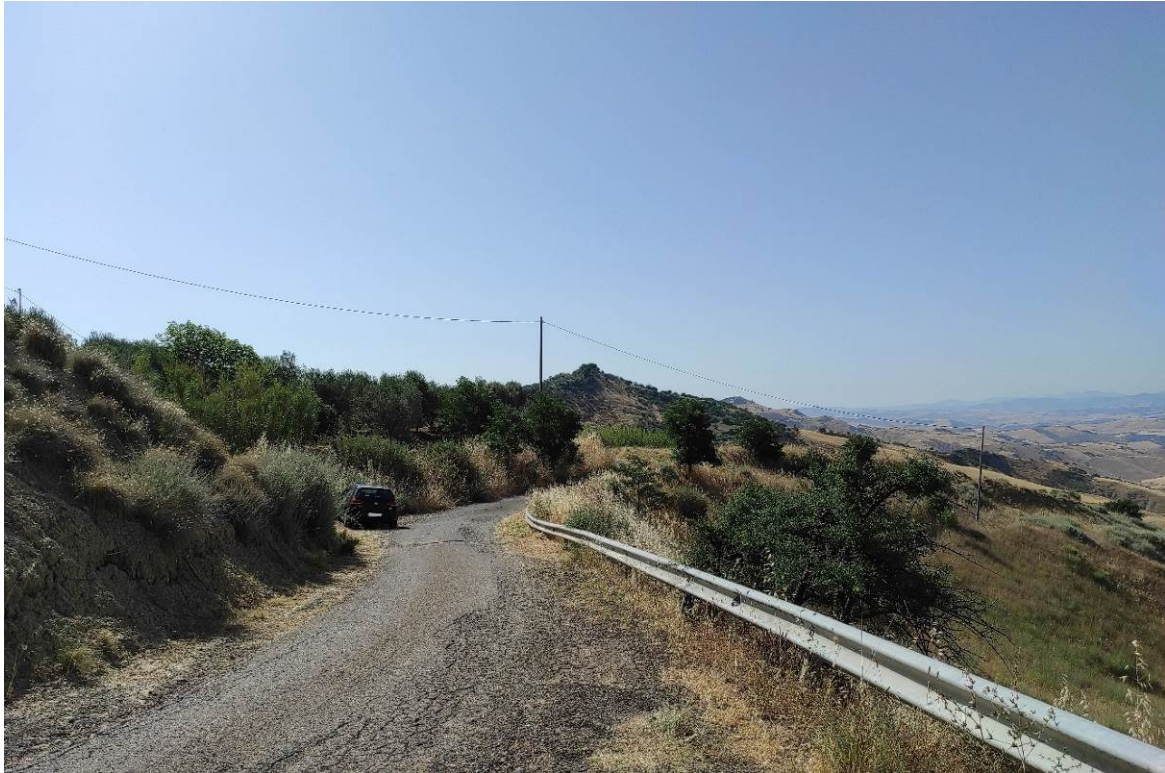
Vista 12_1 a sud dell'urbanizzato di Salandra ante operam
