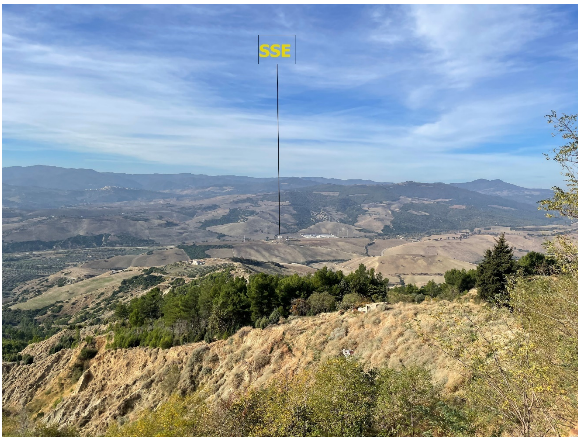
Vista 12 lungo la strada comunale Contrada Guardiola post operam
