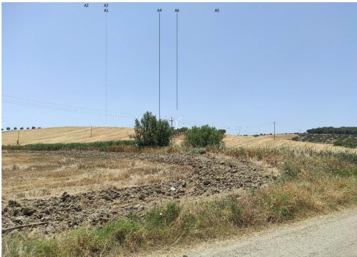
Vista 1_2a lungo la SP Ferrandina-Stigliano post operam
