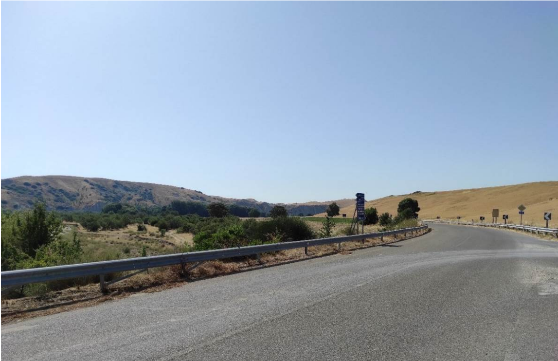
Vista 11 lungo la SP4 (Viadotto Salandrella V), lungo nr. 66 MT tratturo di San Leonardo, ante operam
