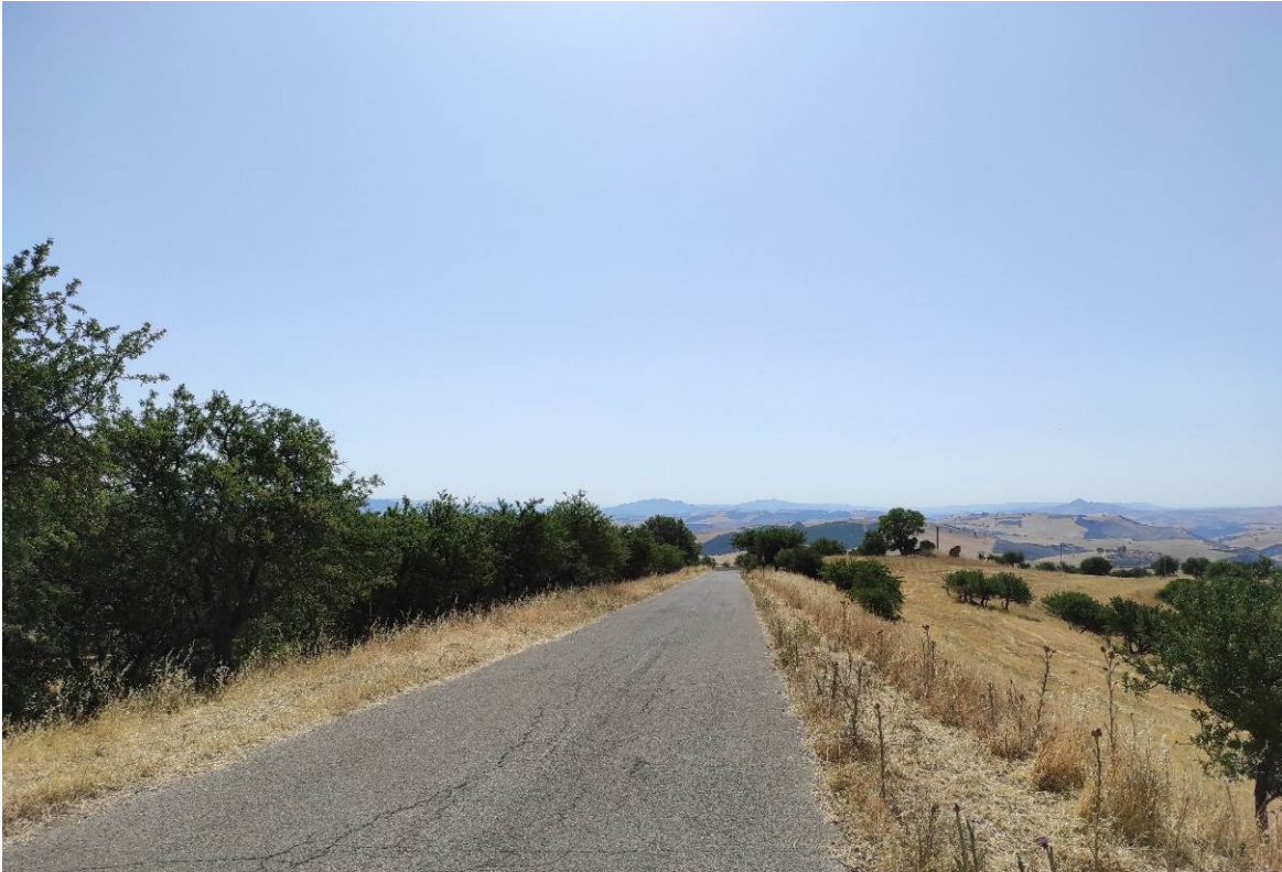
Vista 2_2 lungo la SP4, lungo nr. 65 MT tratturo di Priati, ante operam
