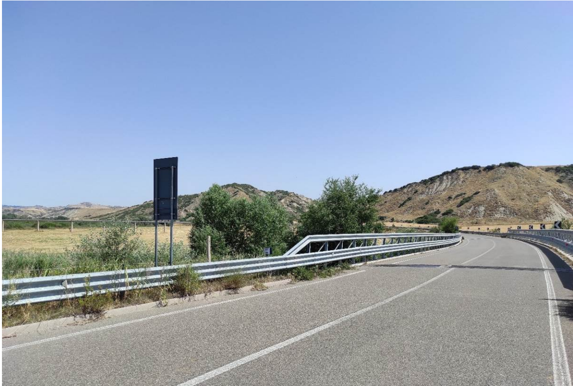
Vista 4 lungo la SP4 ante operam
