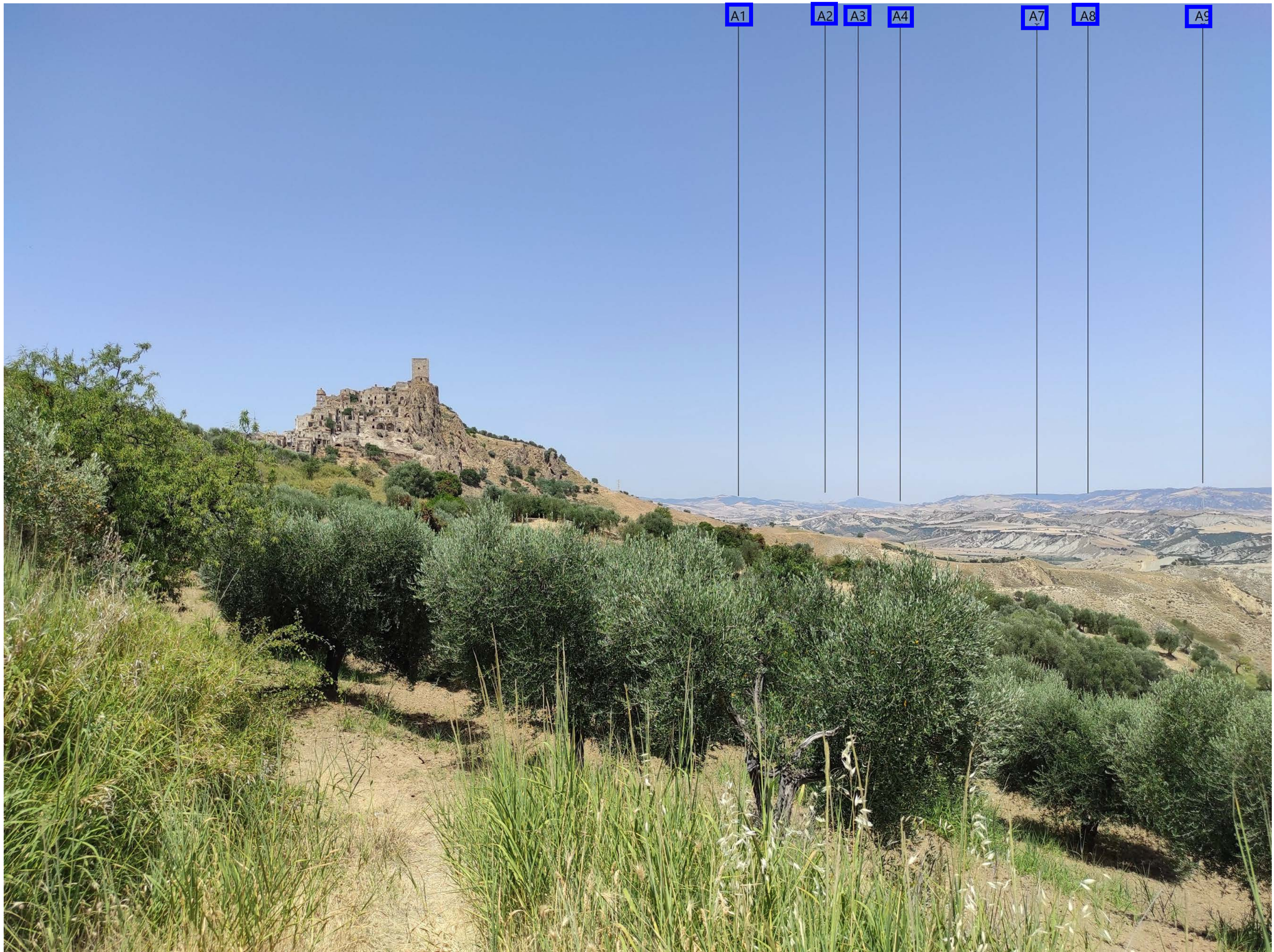
Punto di scatto V9_2a POST OPERAM
