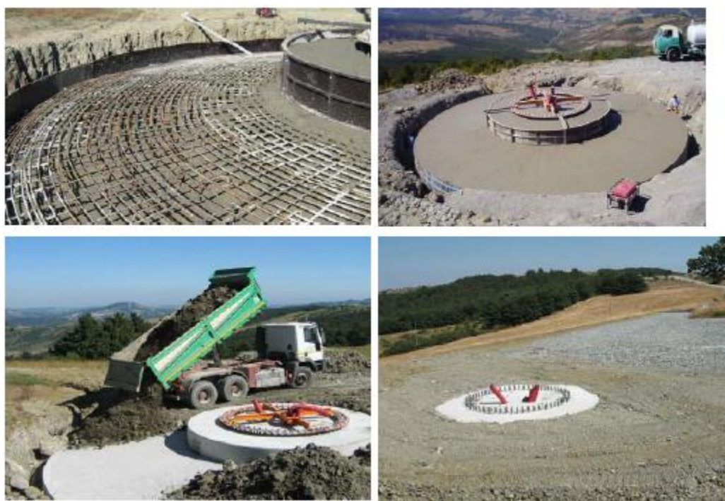
Particolare esecuzione plinti di fondazione
