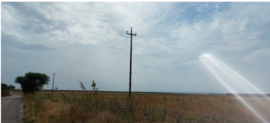
Stato di fatto – Punto di presa fotografica 5a
