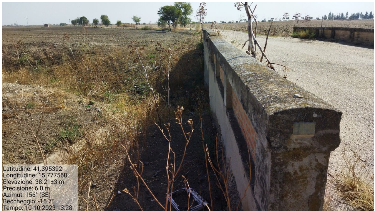
Figura 9: Ponte su SP72.
