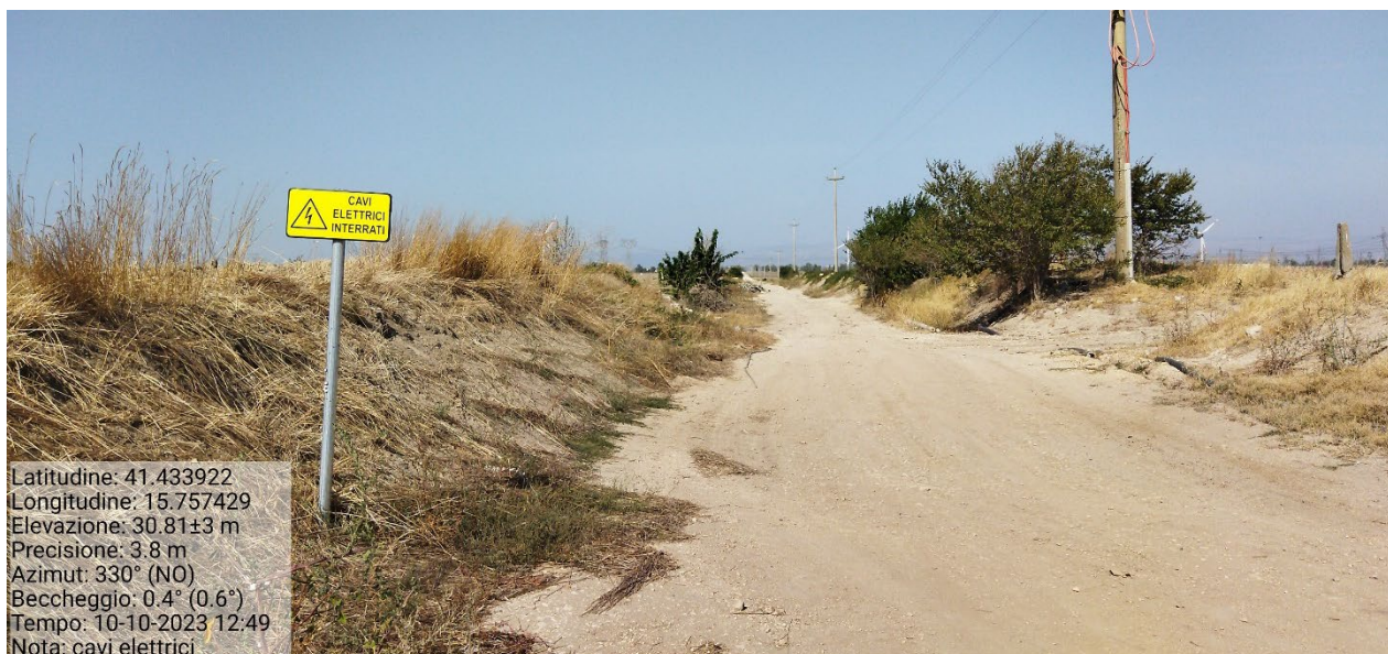
Figura 6: Cavidotto interrato a bordo strada lungo la SP80.
