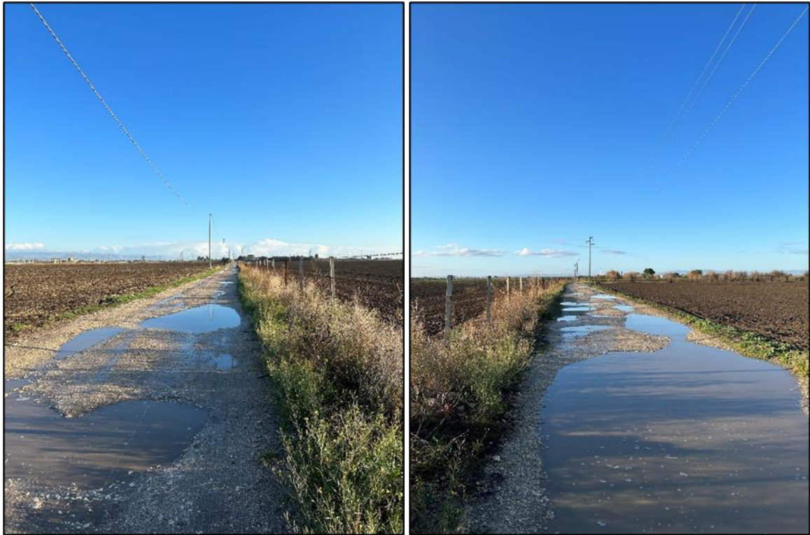
Figura 17 – 18: Viabilità poderale percorsa dal cavidotto
