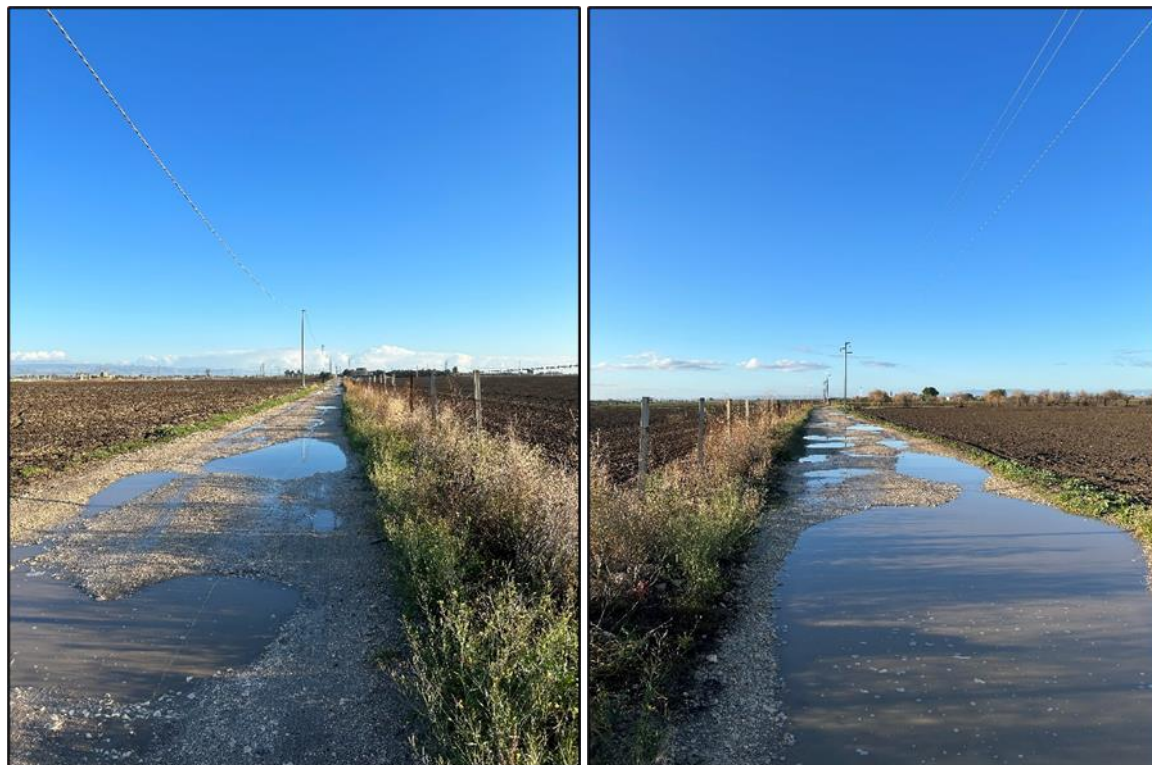
Figura 17 – 18: Viabilità poderale percorsa dal cavidotto
