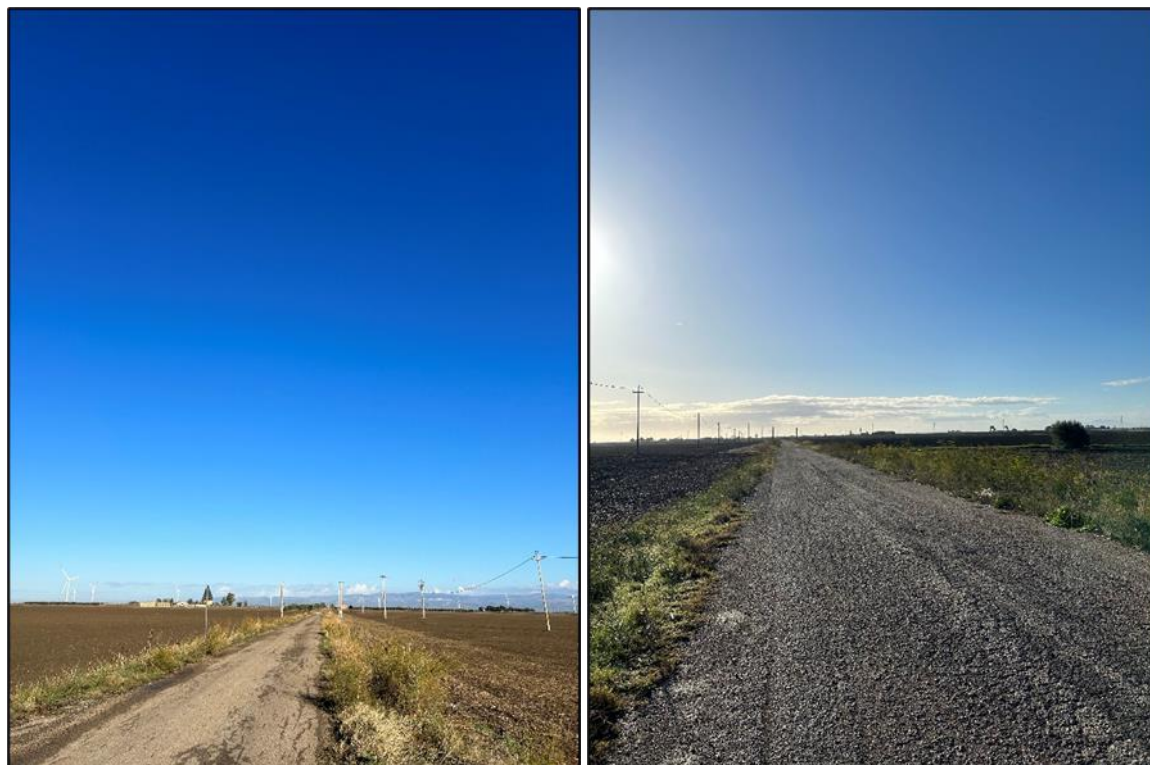
Figura 19 – 20: Strada Statale SS544 e Strada Provinciale SP 80 percorse dal cavidotto
