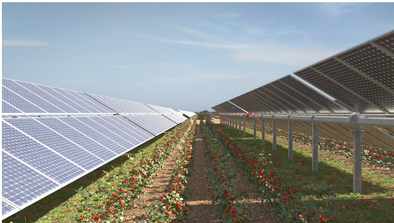
Figura 15: Rappresentazione all'interno dell'impianto agrivoltaico per le colture orticole tra le interfile di pannelli
