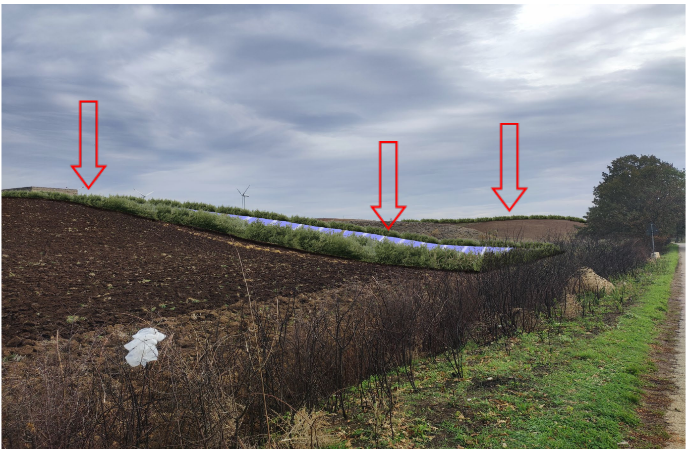
Fig. 28 Punto di presa n. 7 stato di progetto (Strada Provinciale 6)
