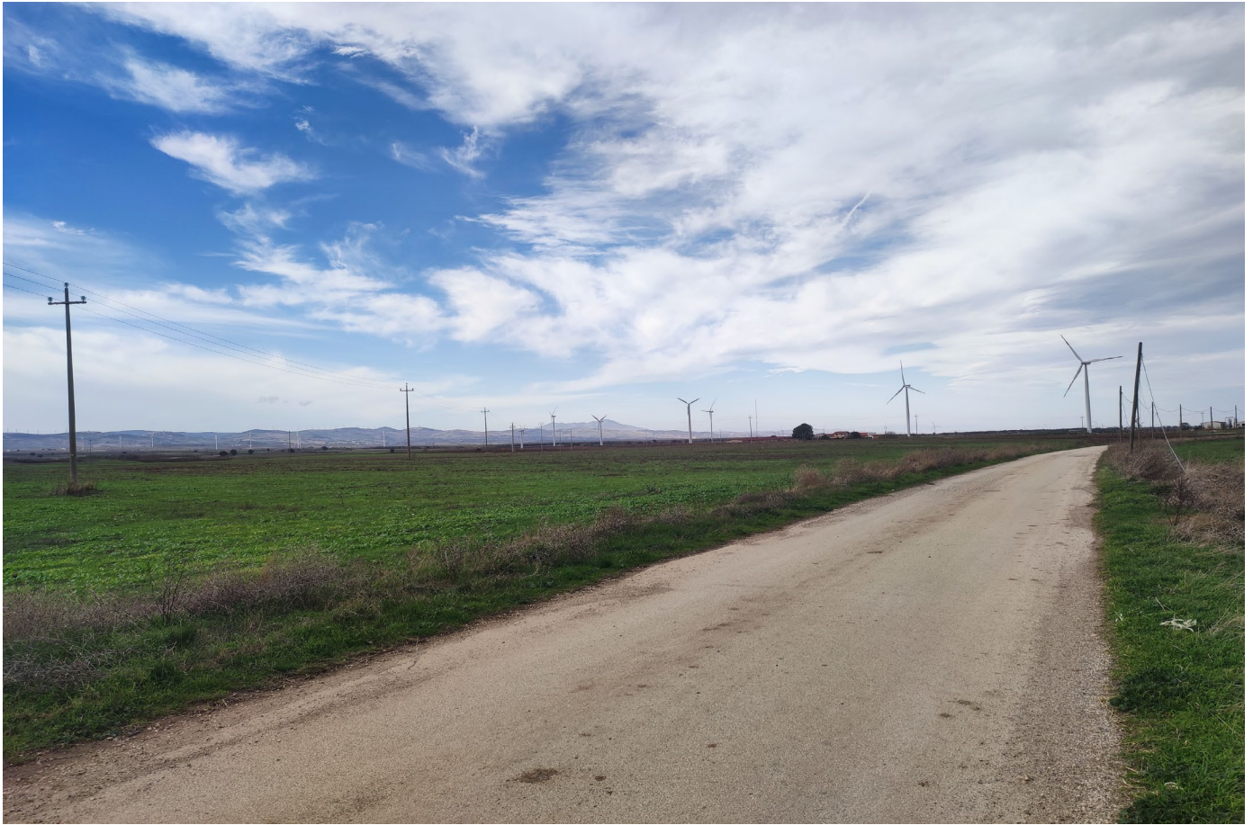
Fig. 7 Punto di presa n. 2 stato di fatto (Mass.a Spesseti)
