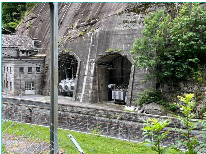
Abbildung 2: Bestehende 'Nische' (rechts im Bild) vom neuen Transformator 220 kV auf der rechten Uferseite, der bestehende Transformator 16 kV wird durch den grösseren ersetzt.
