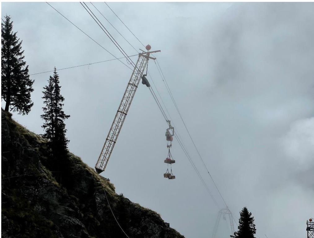
Nadelstütze, mit Seilen abgespannt
