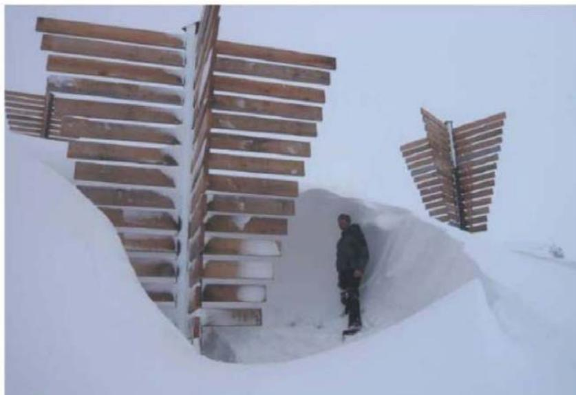
**Abb. 1:** Wirkungsweise einer Kolktafel in Kreuzform: durch die Verwirbelung bildet sich ein Kolkring, sodass das Bauwerk schneefrei bleibt
