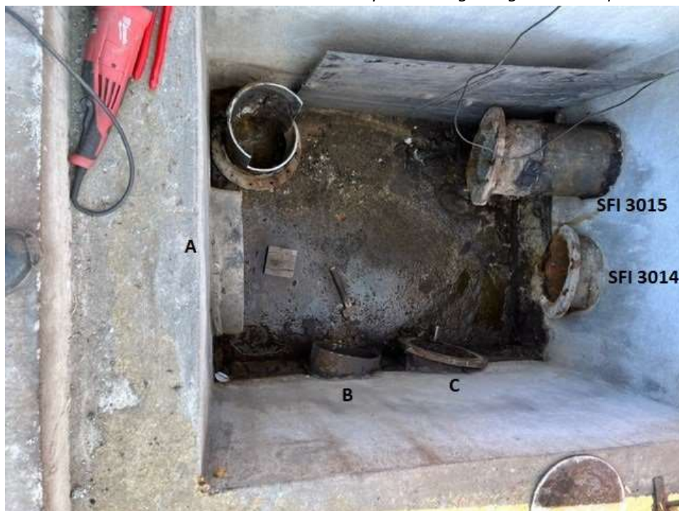
Foto 3: lavori di accorciamento delle tubazioni per una migliore gestione del pozzetto
