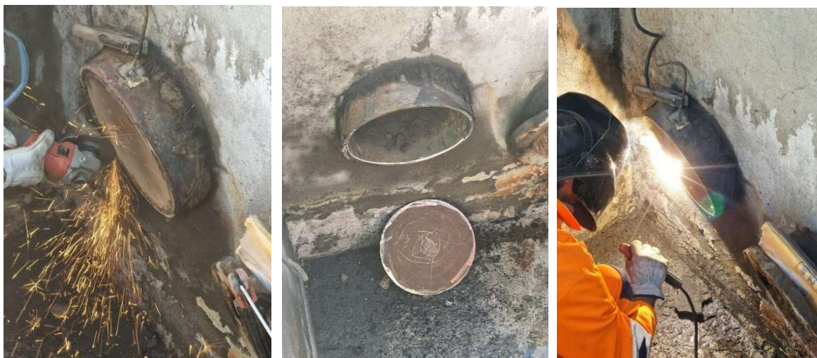
Foto 6: preparazione della sede e saldatura dell’ingresso SFI 3015
