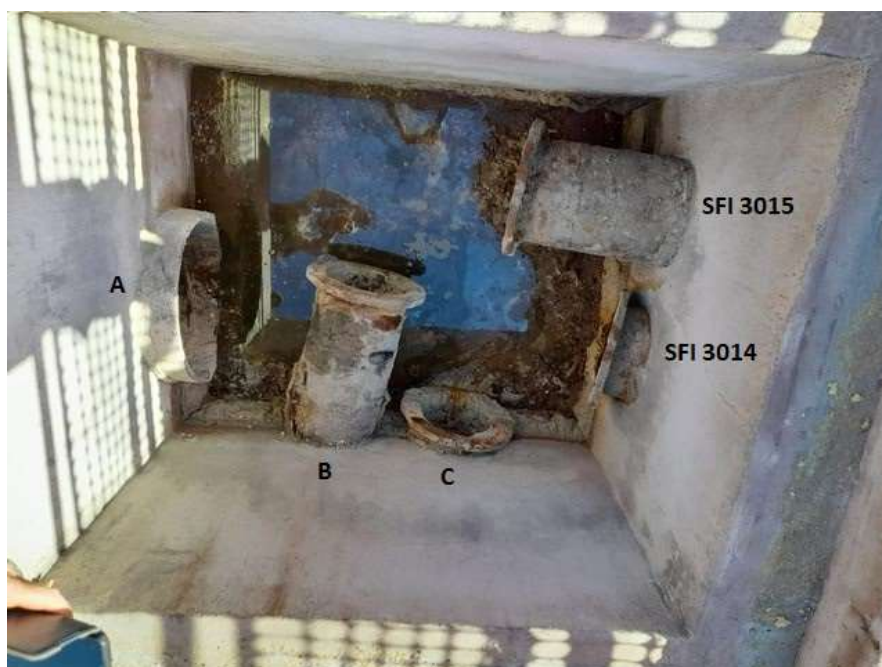
Foto 2: stato prima dell’intervento, sono visibili le due entrate SFI 3014, SFI 3015 e le tre uscite A, B, C
