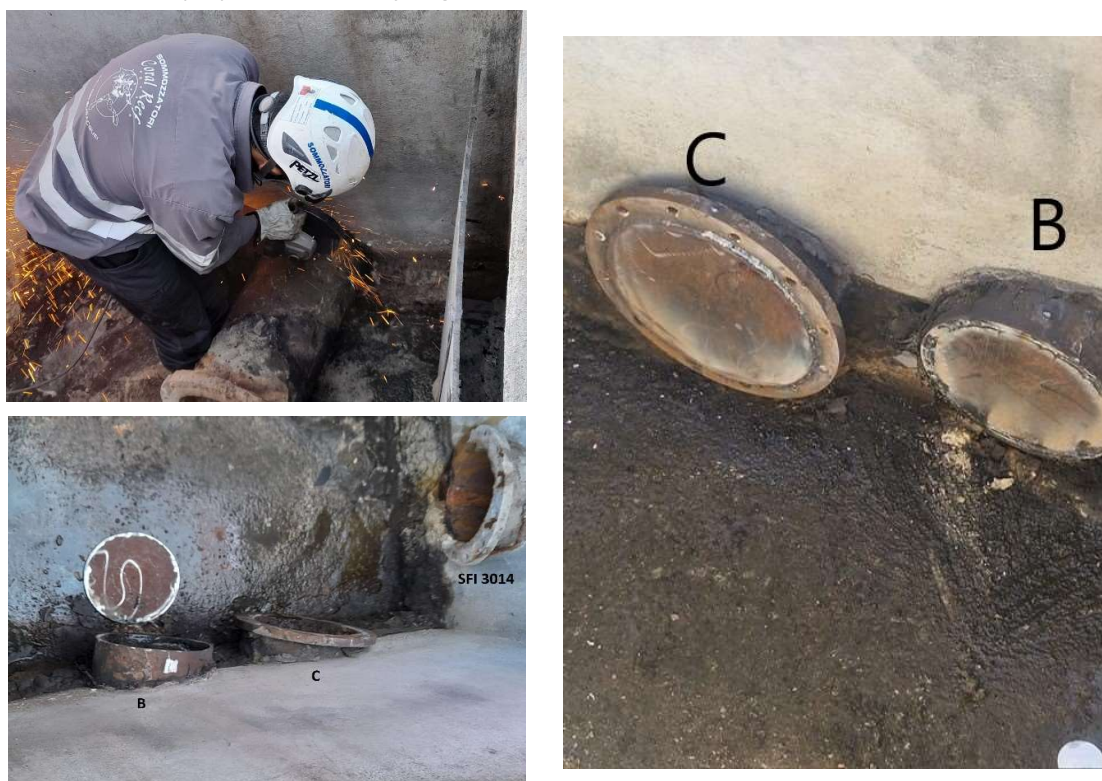
Foto 4: lavori di preparazione delle flange cieche e saldatura delle uscite B, C
