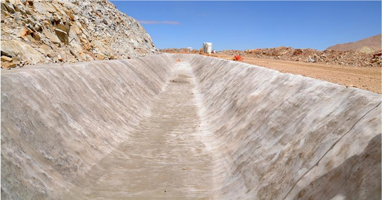
Figura 31 - Esempio di fosso di guardia in terra
