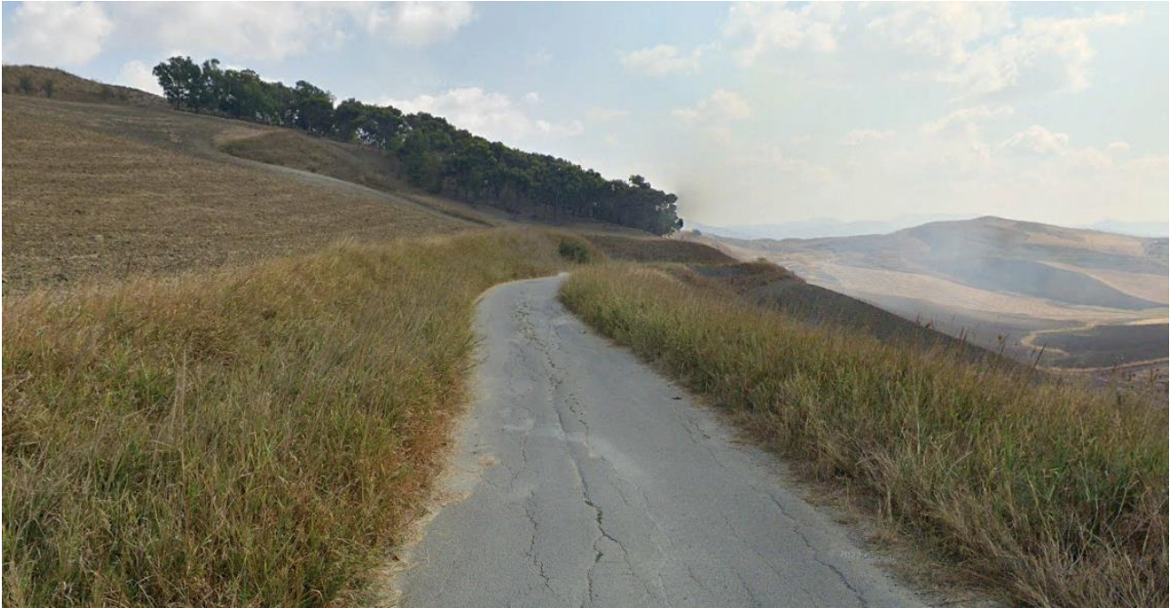
Figura 23 - Viabilità di accesso alla WTG 2
