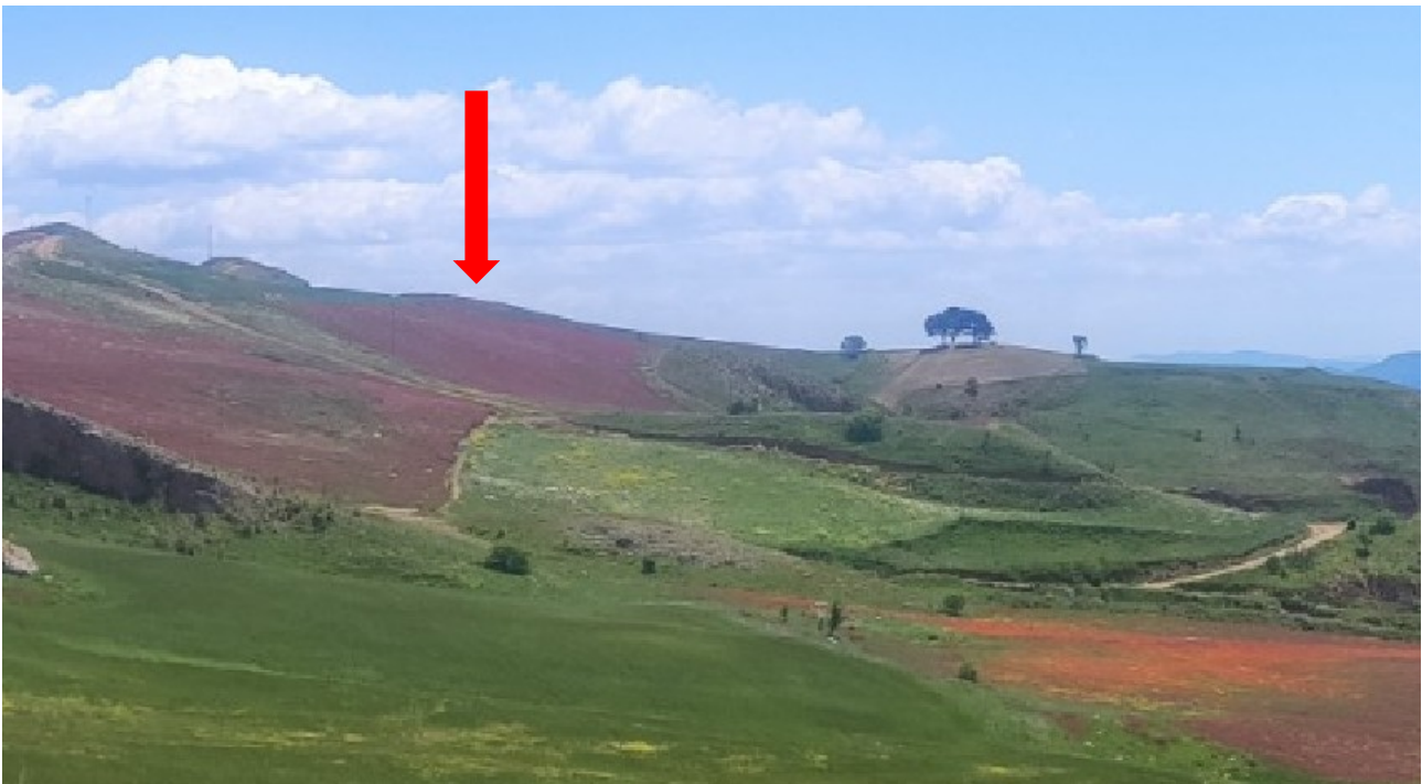
Figura 13- Aerea Torre WTG1
