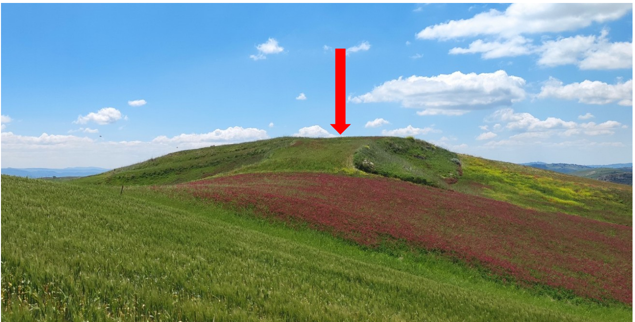
Figura 15- Area Torre WTG3
