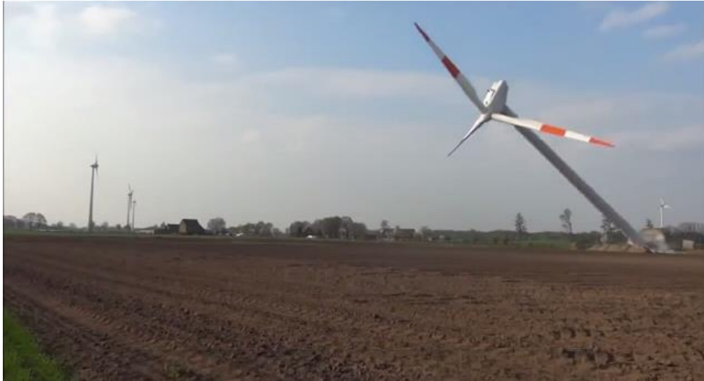
Figura 9- Ribaltamento della torre alla radice
