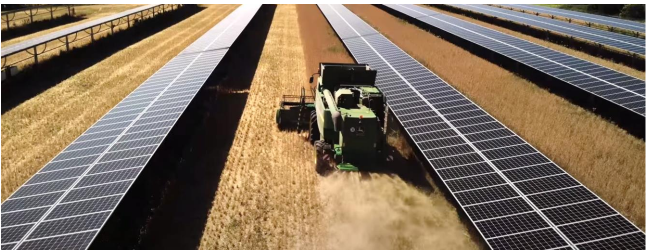
Figura 10 - Particolare di un inseguitore monoassiale est-ovest in un sistema agro-fotovoltaico
