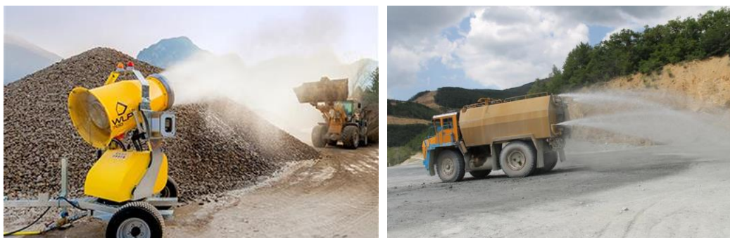
Esempio di Irrorazione delle aree di cantiere –
