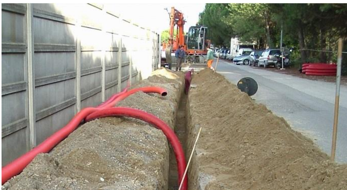
Cantiere per linea elettrica interrata su strada asfaltata
