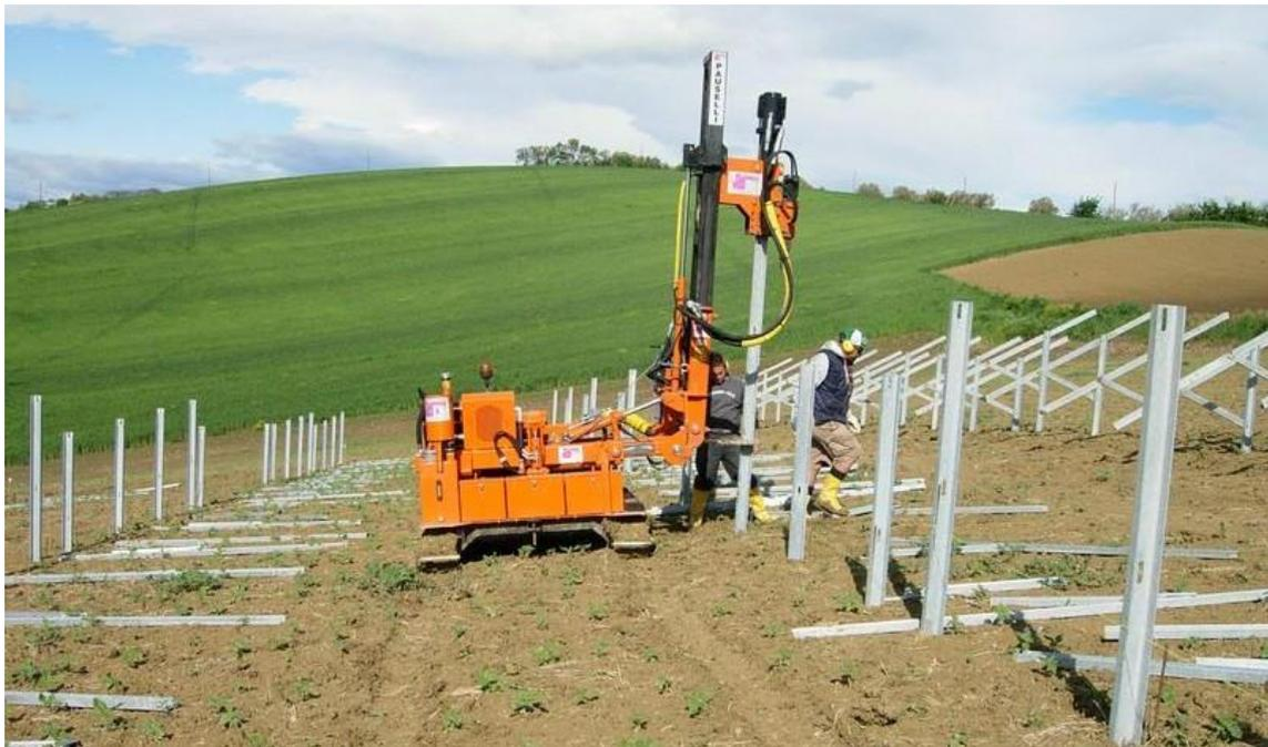
Macchina battipali per l'ancoraggio delle strutture che non richiede opere di scavo
