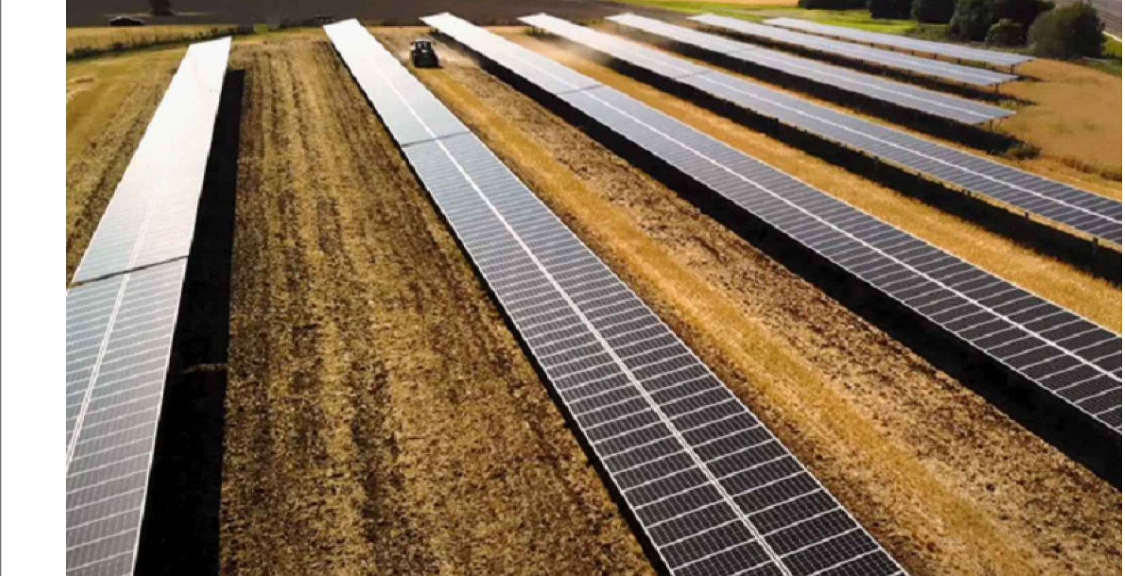
Particolare di un inseguitore monoassiale est-ovest in un sistema agro-fotovoltaico
