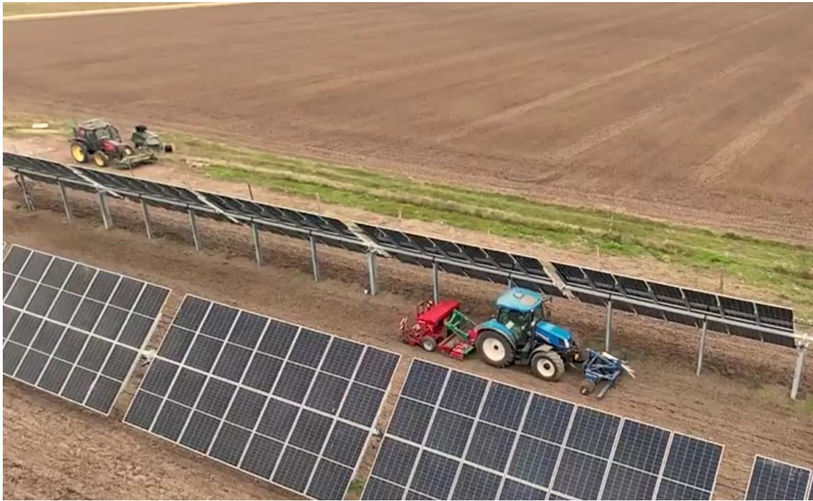
PARTICOLARE DI UN INSEGITORE MONOASSIALE EST-OVEST IN UN SISTEMA AGRO-FOTOVOLTAICO
