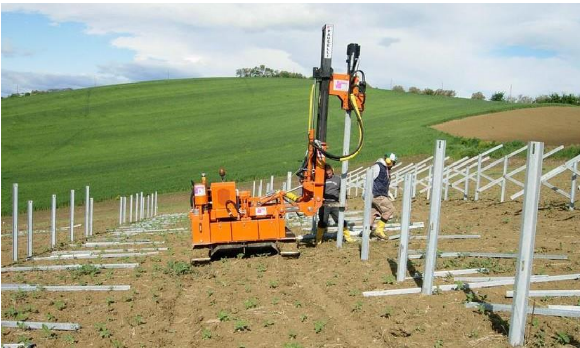
MACCHINA BATTIPALI PER L'ANCORAGGIO DELLE STRUTTURE CHE NON RICHIEDE OPERE DI SCAVO
