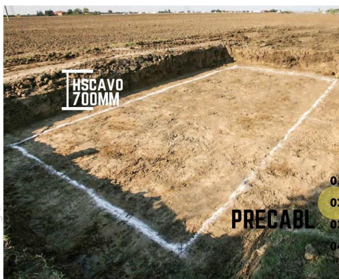
Scavi per la realizzazione del piano di appoggio delle cabine
