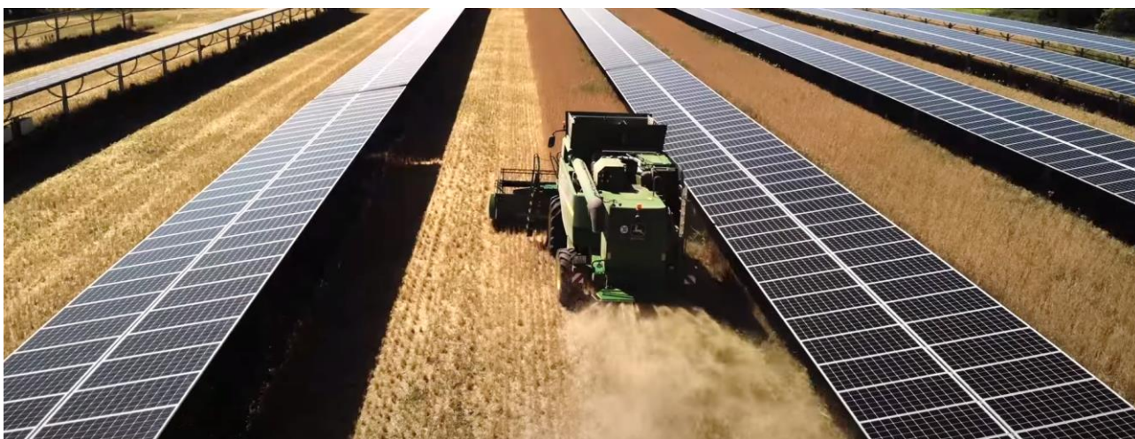
Particolare di un inseguitore monoassiale est-ovest in un sistema agro-fotovoltaico
