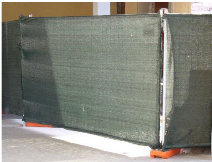
Figura 22: Immagine esemplificativa - telo antipolvere in bandella HDPE
