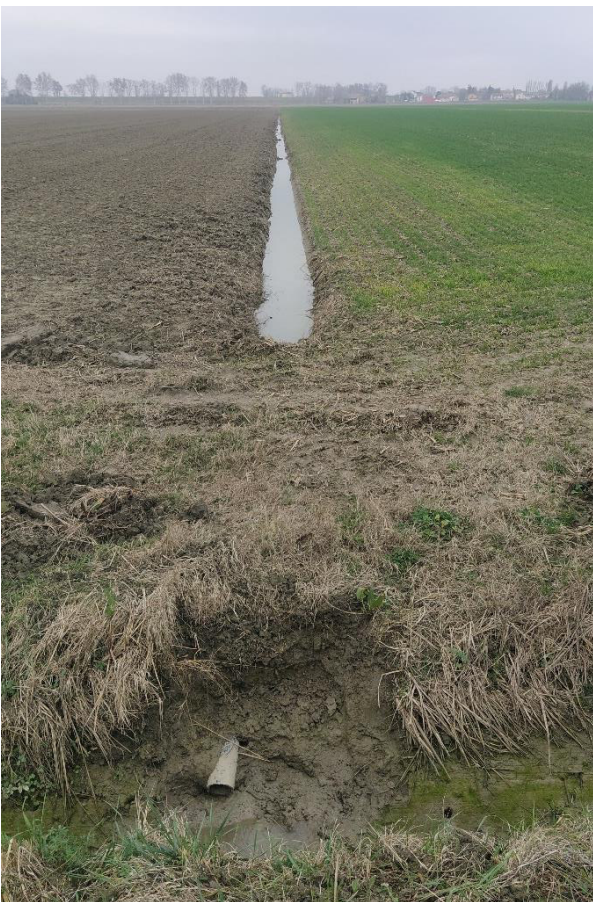
Ripresa 4 - Campo NORD, particolare delle opere di regimazione a sud.
