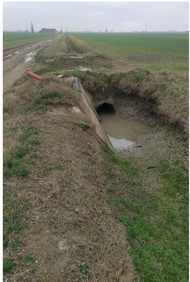
Ripresa 5 - Campo NORD, particolare delle opere di regimazione a est.
