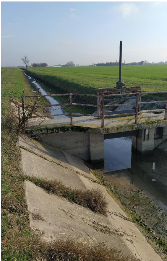
Ripresa 11 - Campo SUD, particolare delle opere di regimazione a ovest.
