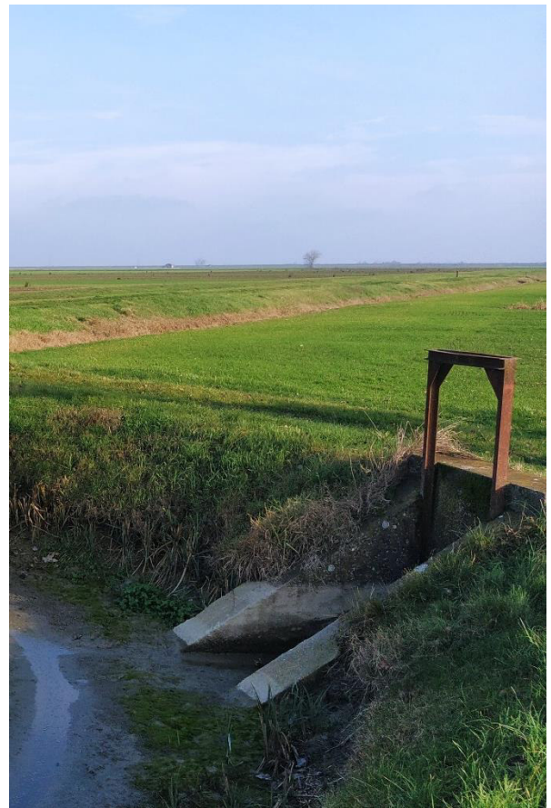
Ripresa 12 - Campo SUD, particolare delle opere di regimazione lungo il canale mediale.
