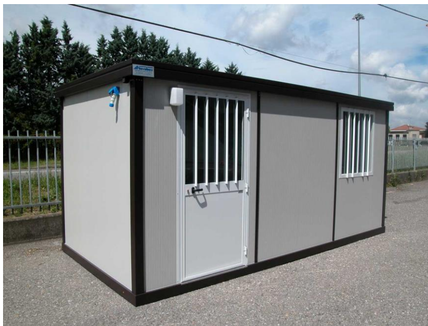
Figura 28 - Esempio di cabina di magazzino
