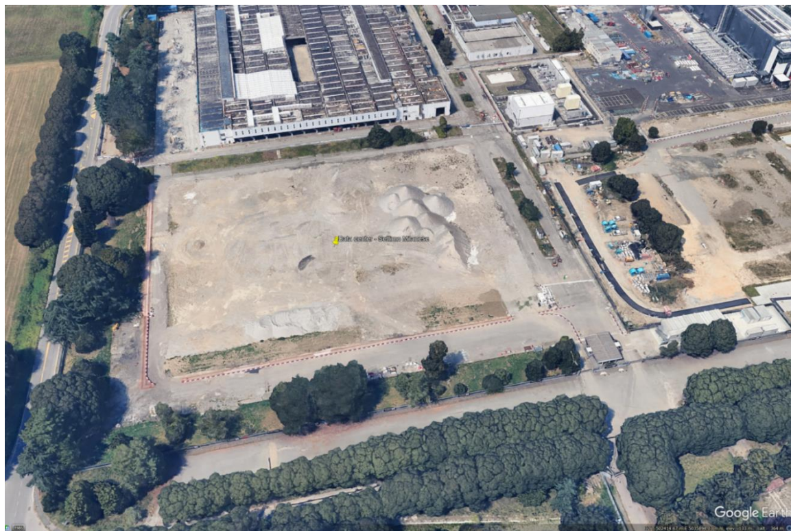
Figura 4-58: Immagine dell'area di intervento
