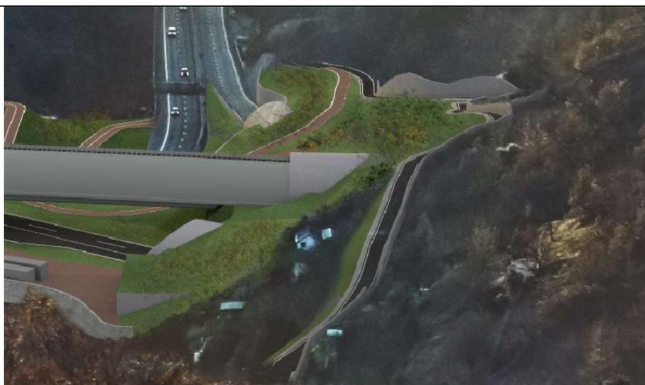
*Figura 33* Vista laterale - Foto simulazione realistica del progetto approvato di sistemazione definitiva delle aree di imbocco situate in corrispondenza della Val Torbella immediatamente ad Ovest delle gallerie Montesperone - Deviazioni viabilità interferita via Torbella a monte degli imbocchi realizzata con incisioni del versante sostenute da paratie di micropali rivestite
