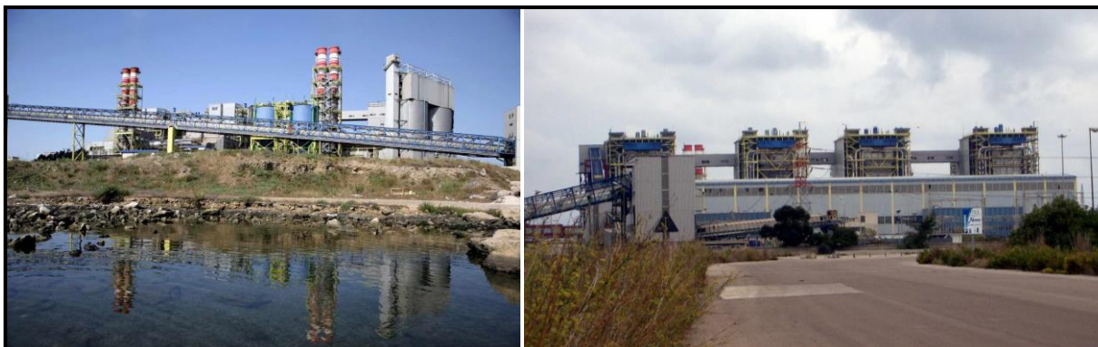
Figura 4.2.8.1d Vista della Centrale Brindisi Nord
