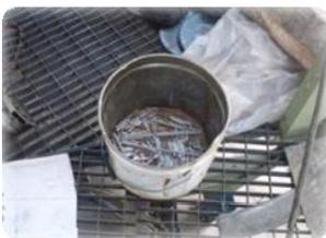
Durante le attività di molatura e/o di saldatura si prevede la presenza di sfridi di elettrodi consumati e dischi per mole consumati. Ogni saldatore dovrà avere a disposizione un contenitore per la raccolta degli elettrodi utilizzati.
