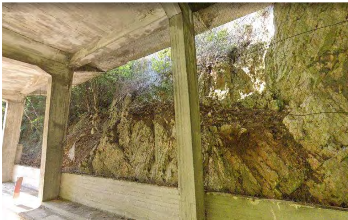
Figura 3 -Particolare consolidamento Galleria parietale- direzione Piedipaterno
