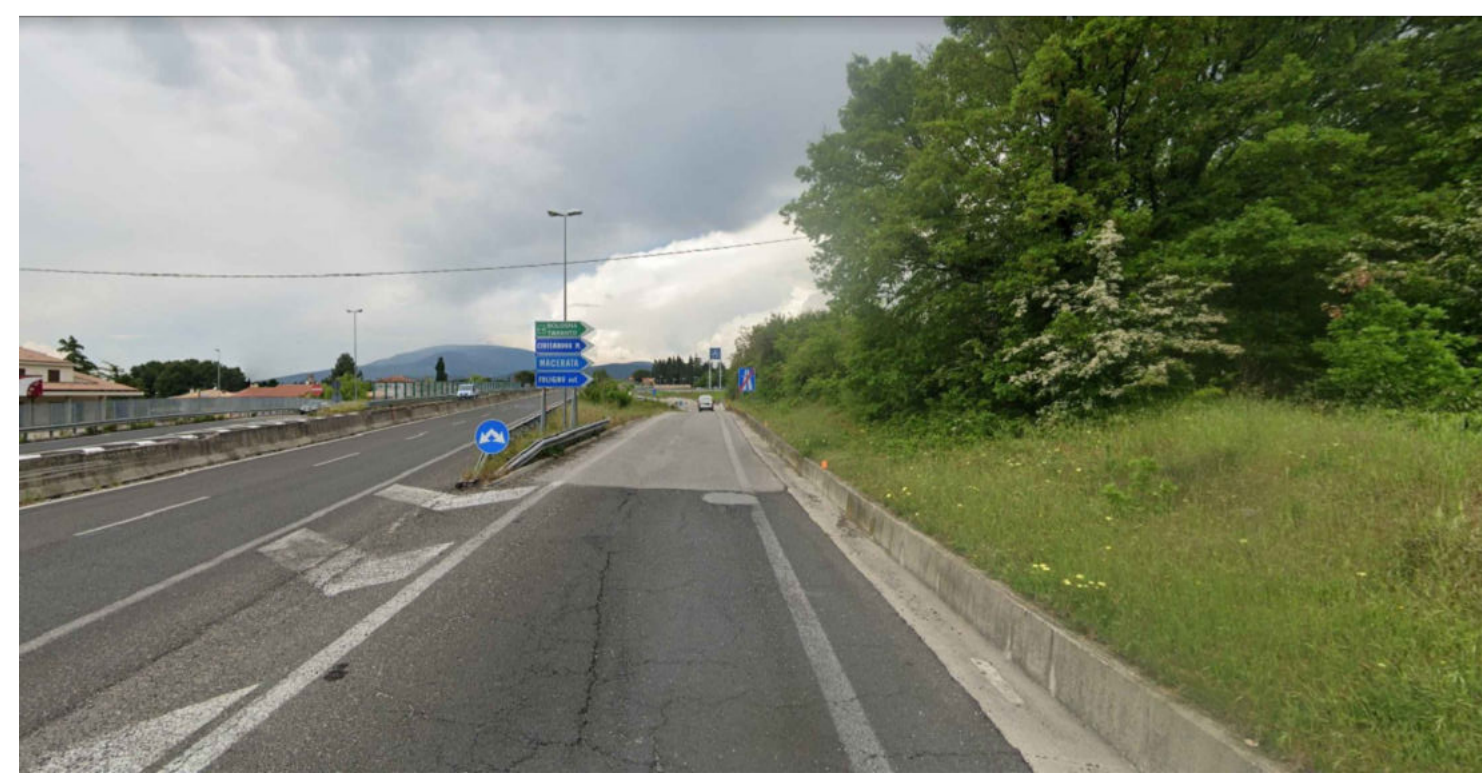
FOTO 2 - Deviazione sullo svincolo della S.S. 3
